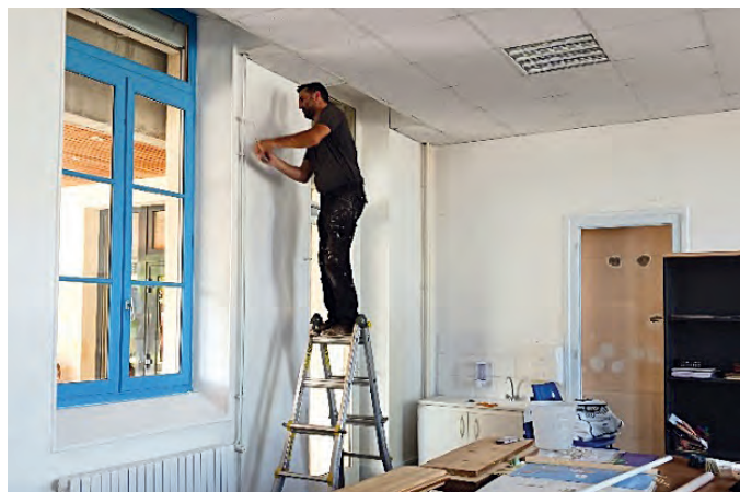
Après le déménagement de la bibliothèque, des travaux de réfection de la salle d'accueil du périscolaire s'imposaient.
