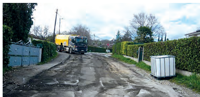
Réfection du tapis enrobé de l'allée des Muriers entièrement pris en charge par Vienne-Condrieu-Agglomération
