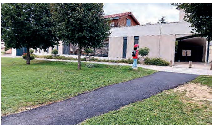
Goudronnage de la rampe passage piétons devant l'école.
