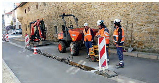
Réfection canalisation chemin de l'église.
