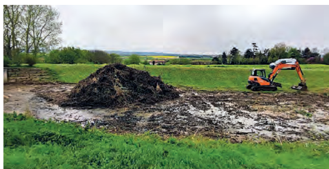
Curage bassin de rétention, derrière les containers de tri sélectif.
