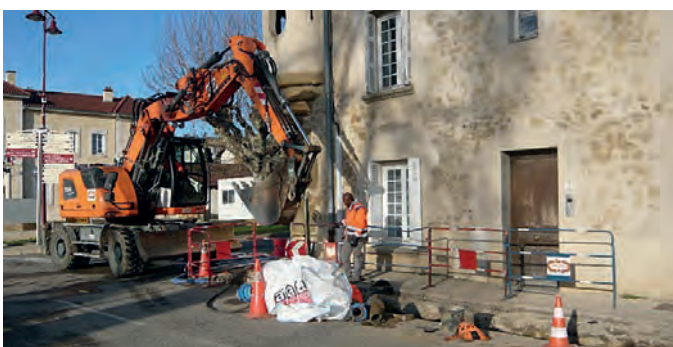
Pour remédier aux pertes d'eau potable, sur de vieilles canalisations en fibrociment, Vienne-Condrieu Agglomération est intervenue devant le château.
