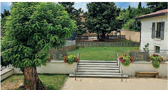
Pose de garde-corps personnalisé
