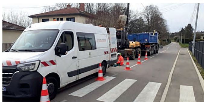
Reprise d'une canalisation d'eau pluviale chemin de Sambillot
