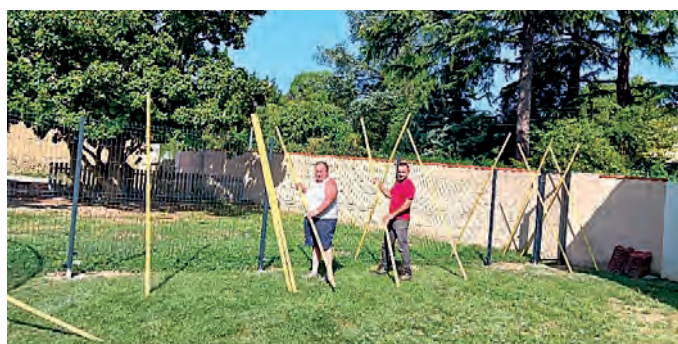
Pose d'un grillage de sécurisation à l'école maternelle.
