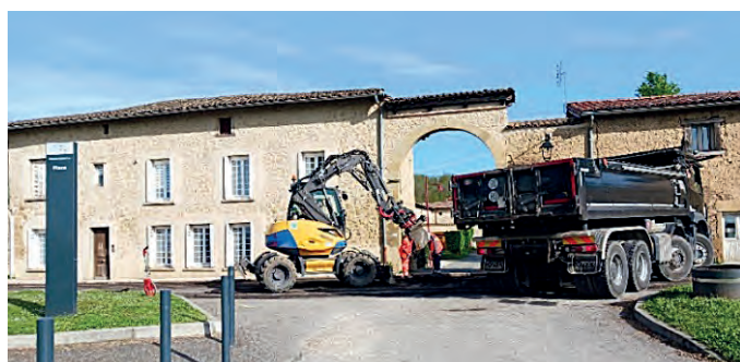
Réfection de l'enrobé route du château
