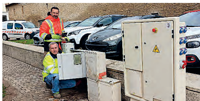
Installation nouveau tableau électrique commun
